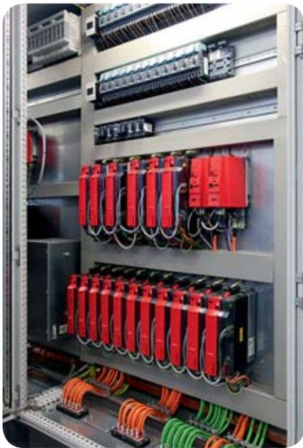
Klassische Schaltschranklösung: In einer Sägemaschine werden die Motoren durch Umrichter angesteuert.
